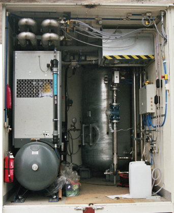
Service rum: kompressor, flödesmätning, vattentank och tillsatsdosering
